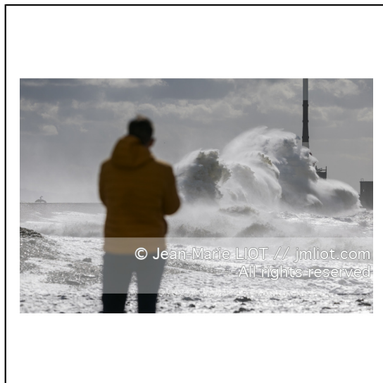
Gosses vagues se fracassant sur la digue du Port du Havre pendant la tempête Benjamin, le 23 octobre 2025, Photo © Jean-Marie LIOT ### Huge waves crashing against the breakwater of the Port of Le Havre during Storm Benjamin, October 23, 2025, Photo © Jean-Marie LIOT
